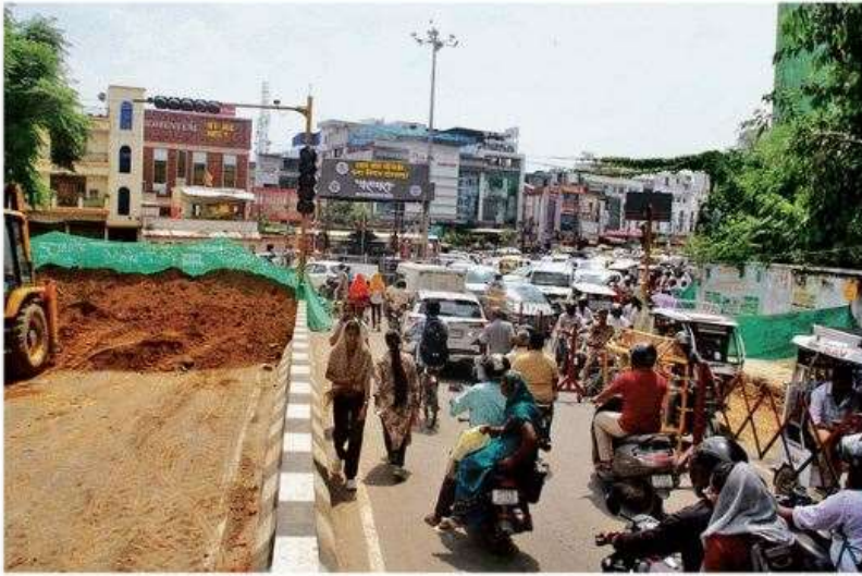
छात्रसंघ चौक पर हो रहा नाला निर्माण • जागरण
